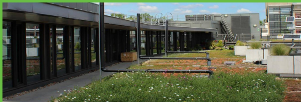
Toiture végétalisée polyvalente sur le campus de South Kensington de Imperial College London.
